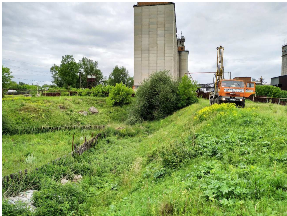
б) вид на участок изысканий в районе проектируемой КНС
