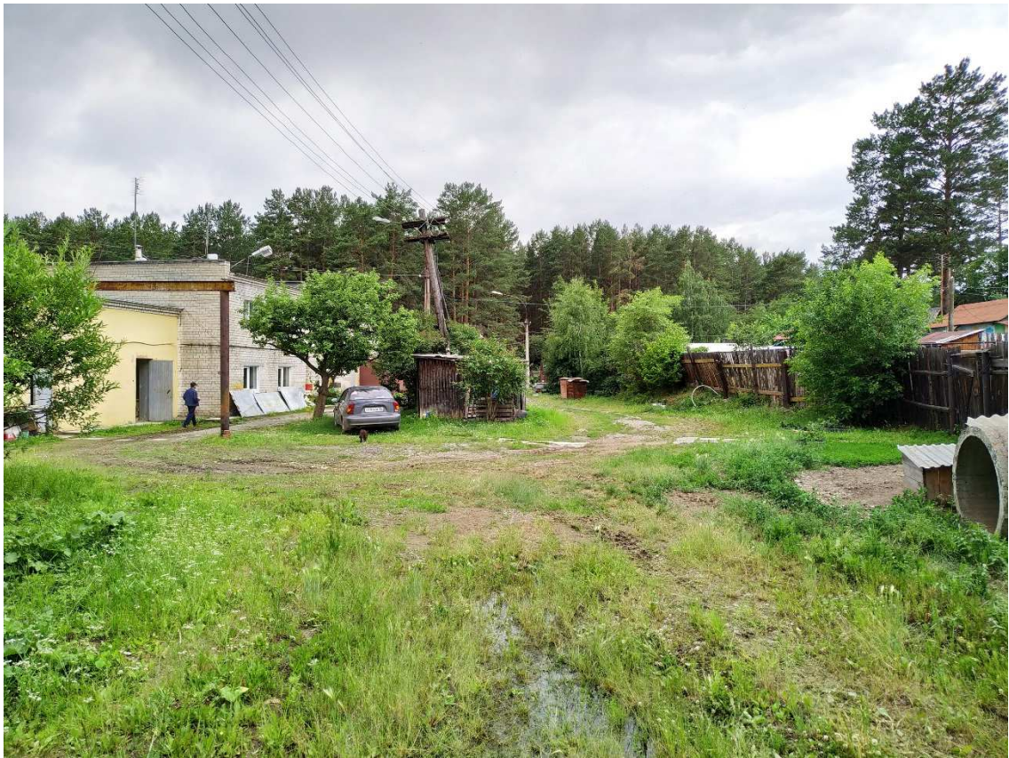
г) территория очистных сооружений п.Светлый
