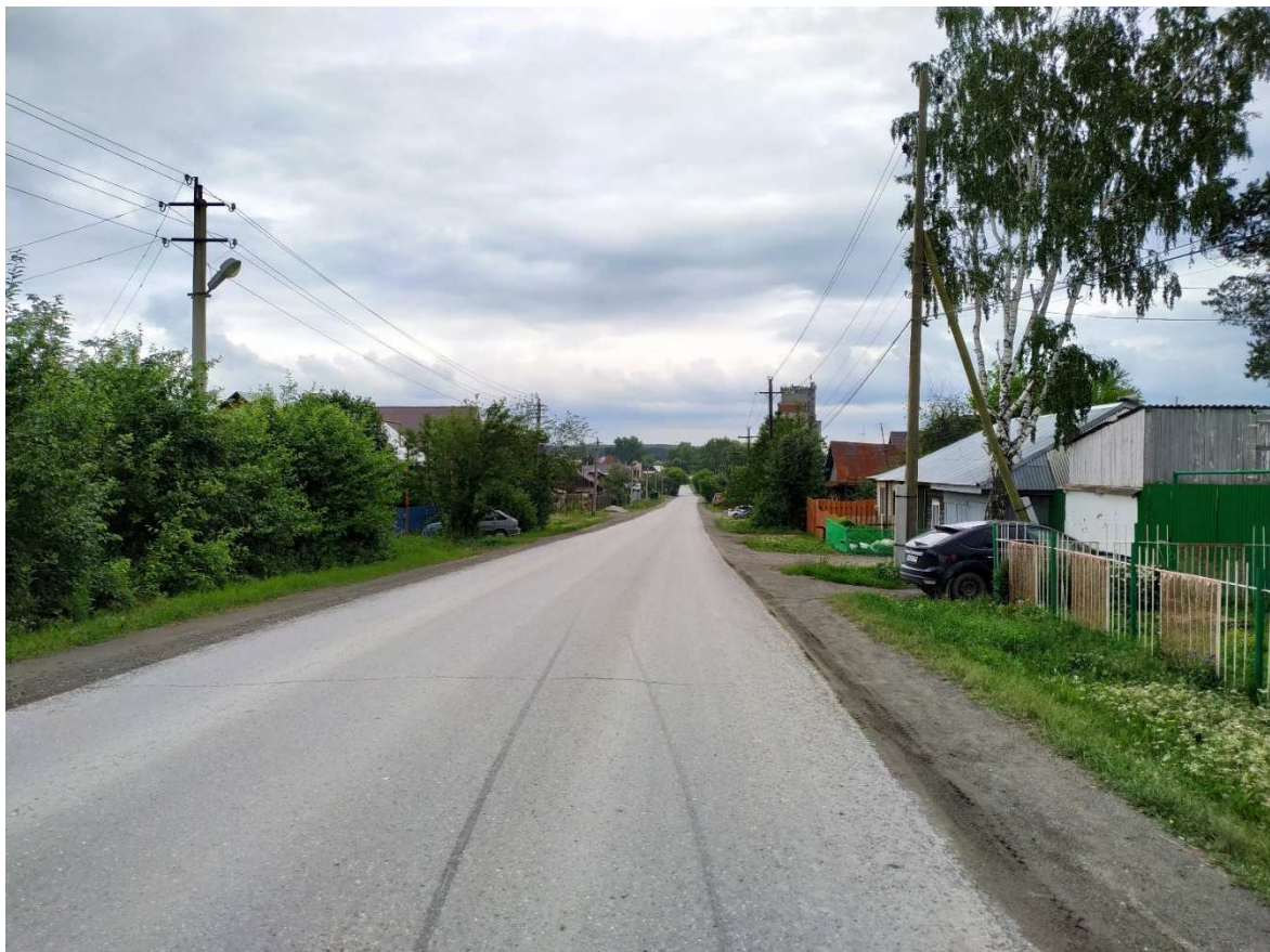
а) вид на западную часть трассы изысканий
